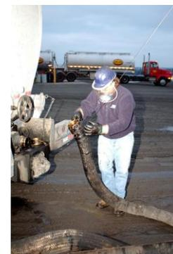
À moins d'arrangements spécifiques, les liants asphaltiques ne devraient pas être déchargés d'une remorque au moyen de la pompe du camion (car la température extrêmement élevée des produits endommagera la pompe de transvasement du camion).
